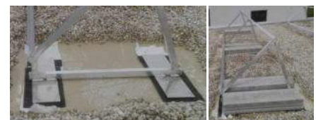
Laschen für Betonbeschwerung
